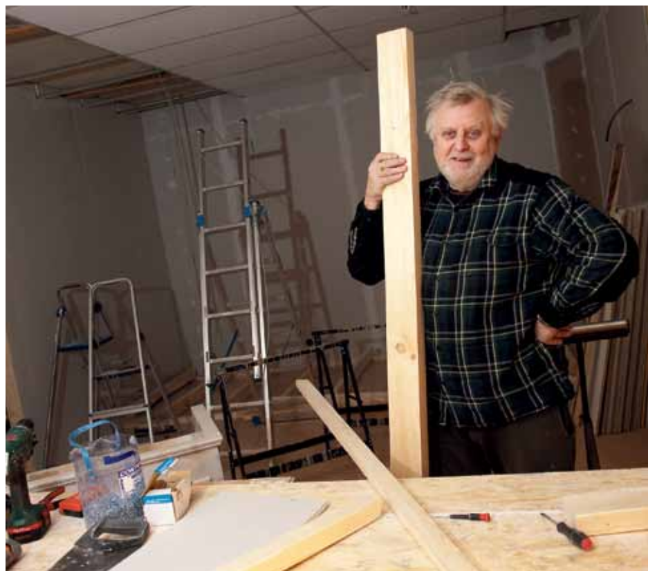
« La première production avec ma scierie à ruban est allée à la loge », raconte Gunnar Thyberg, au milieu du chantier de construction de la nouvelle salle des Odd Fellows à Hagfors.
