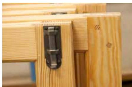
• Les ouvrants sont assemblés par des chevilles en bois pour pouvoir remplacer plus facilement des parties endommagées.
